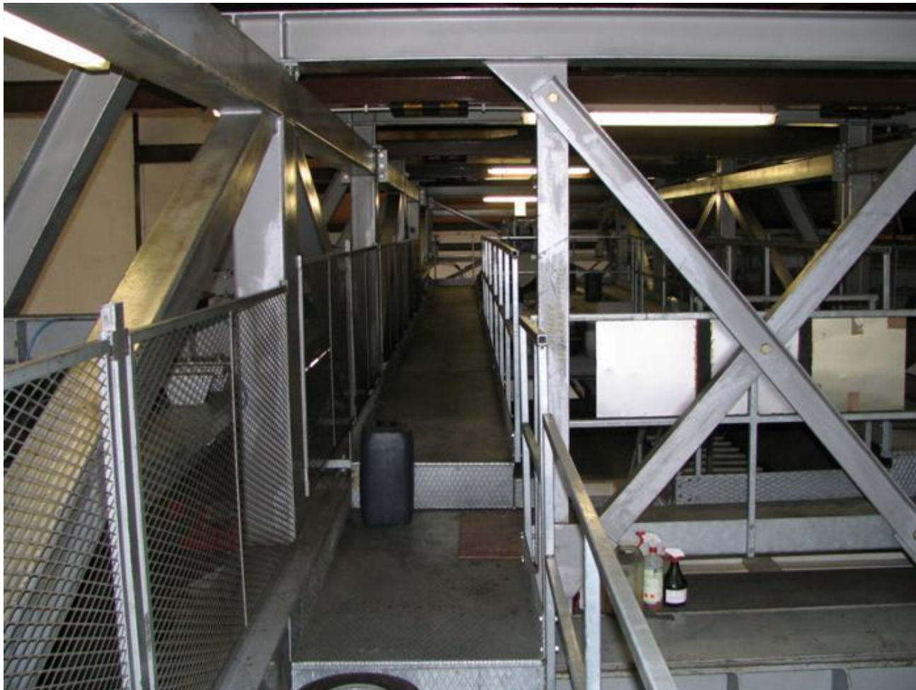
Несущие металлоконструкции и зона сервисного обслуживания
